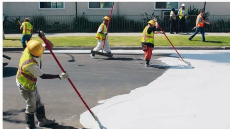
Abbildung 82: Hitzereduktion über einen reflektierenden Strassenanstrich – das Pilotprojekt «Coole Pavement» in Los Angeles
